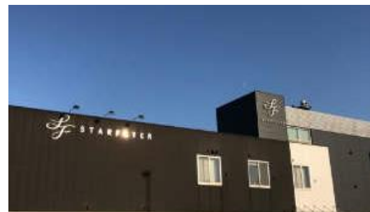
（写真②）北九州空港旅客ターミナルビル施設増設工事
