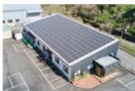
本社事務所屋上
