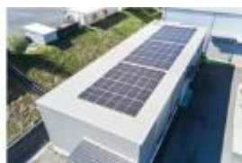
組立工場屋上
