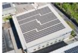
第二工場屋上
