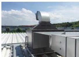
**クライメートウィザード（間接蒸発冷却式空調機）**
