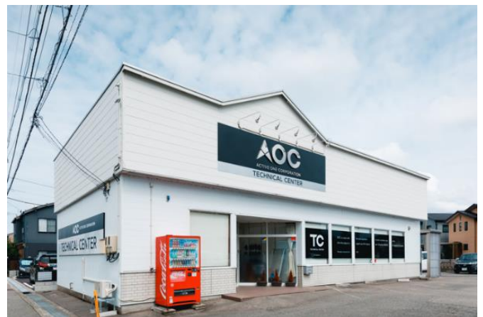
写真③ テクニカルセンター 当社より提供
